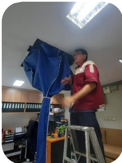
ภาพที่ 2-3.1.2(4) อนุรักษ์พลังงานโดยการล้างแผงกรองอากาศ และคอยล์ร้อนเป็นประจำ
