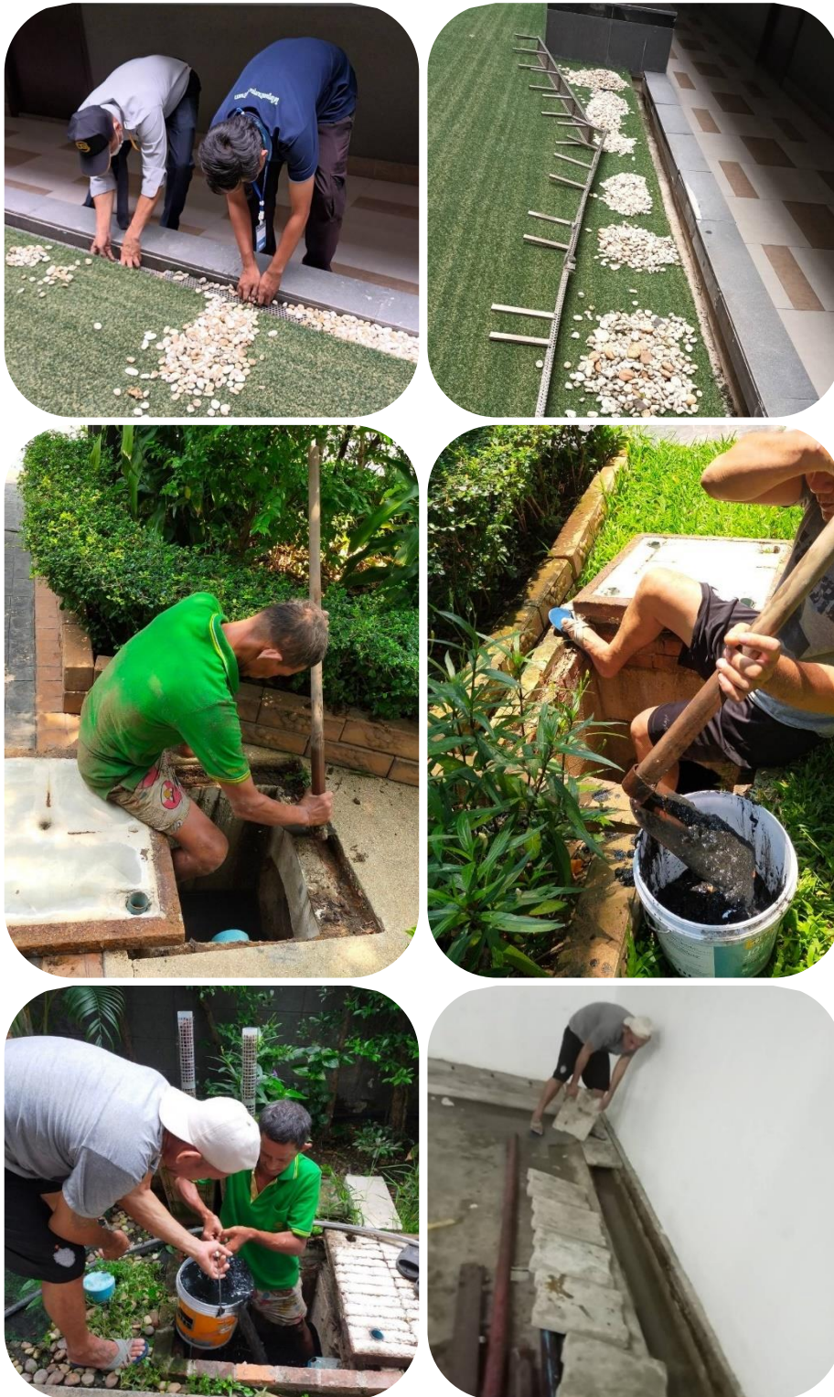
ภาพที่ 2-3.2(1) การขุดลอกที่ระบายน้ำ และตักตะกอน
