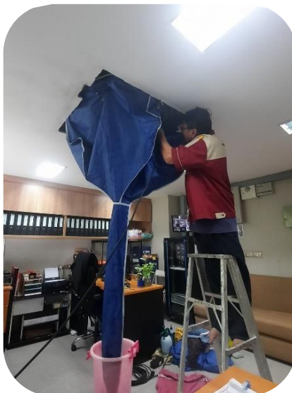
ภาพที่ 2-3.1.2(4) อนุรักษ์พลังงานโดยการล้างแผงกรองอากาศ และคอยล์ร้อนเป็นประจำ
